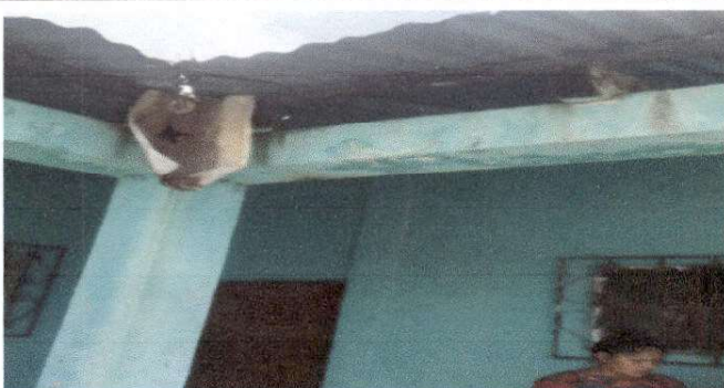
Foto 3: Sustrucción de canal de pvc
